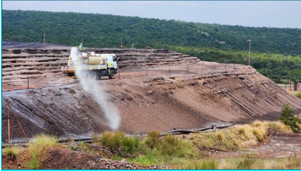
Se está llevando a cabo una rehabilitación simultánea en la TSF5 donde los taludes están siendo hidrosebrados, lo que proporciona rápidamente una superficie con vegetación para evitar la generación de polvo
