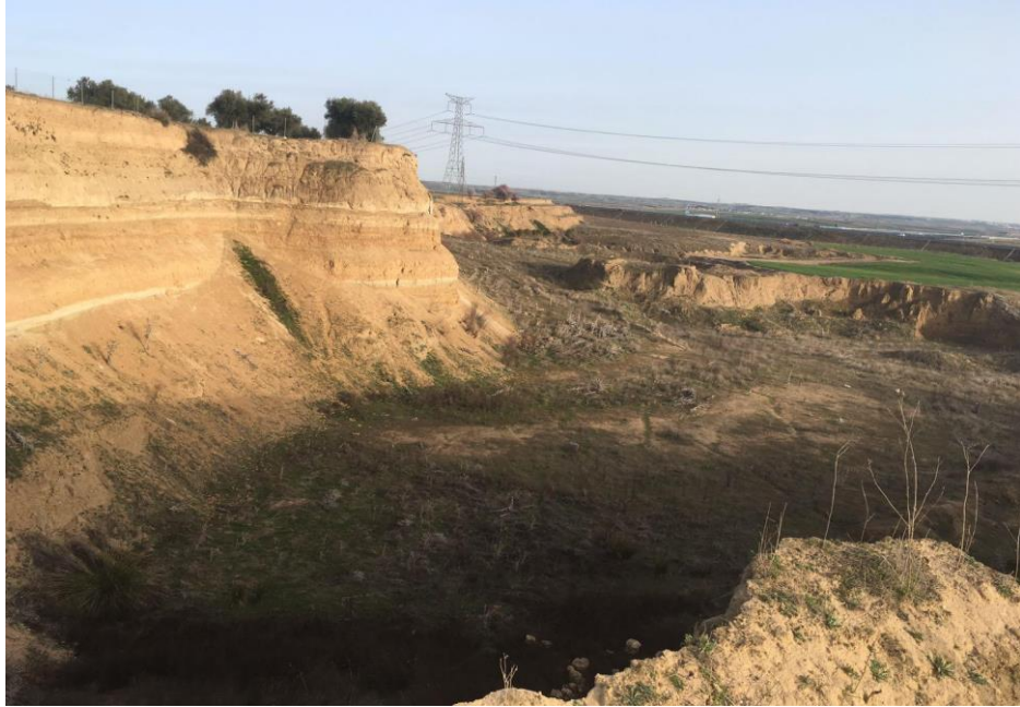
Desmonte en Mina Toledo A
