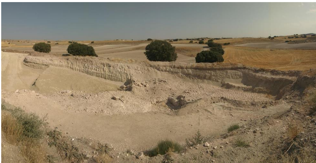
Trabajos de desmonte en Mina Cristina. Toledo.
