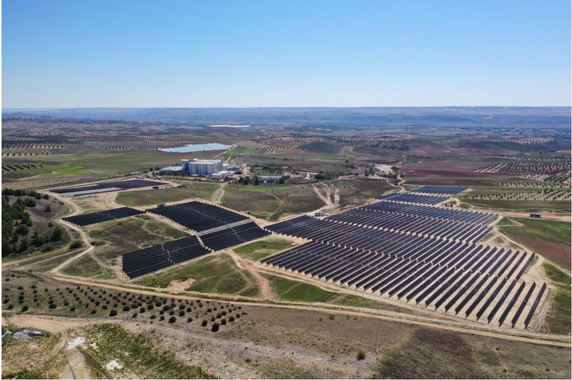
Instalación solar fotovoltaica de autoconsumo "PFV Sulquisa I"
