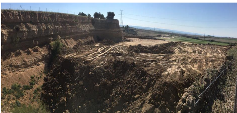
Explotación en Mina Toledo A
