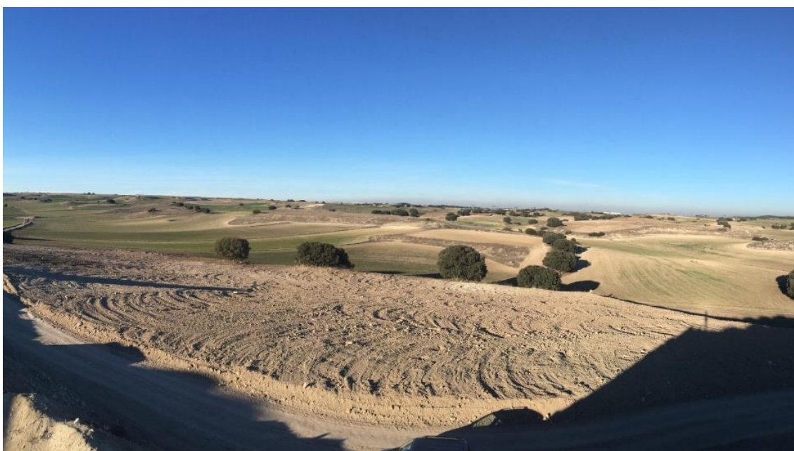
Trabajos de restitución en Mina Cristina. Toledo.
