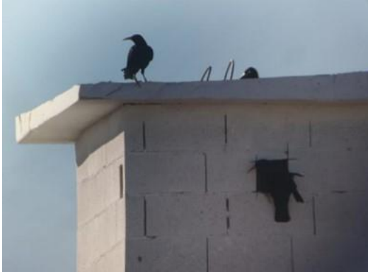
Pareja de Chova piquirroja examinando uno de los nidales del primillar construido en 2022
