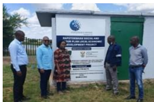
Exterior de la estación de bombeo
