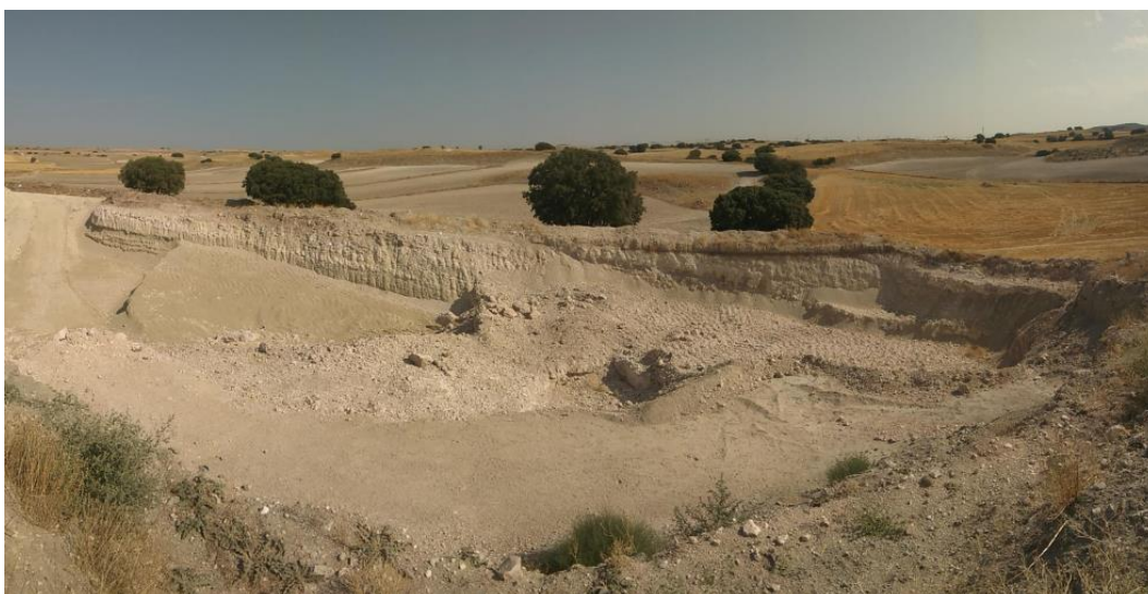
Trabajos de desmonte en Mina Cristina. Toledo.
