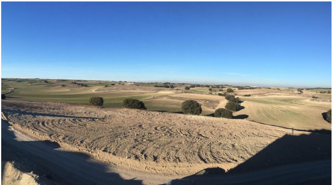
Trabajos de restitución en Mina Cristina. Toledo.
