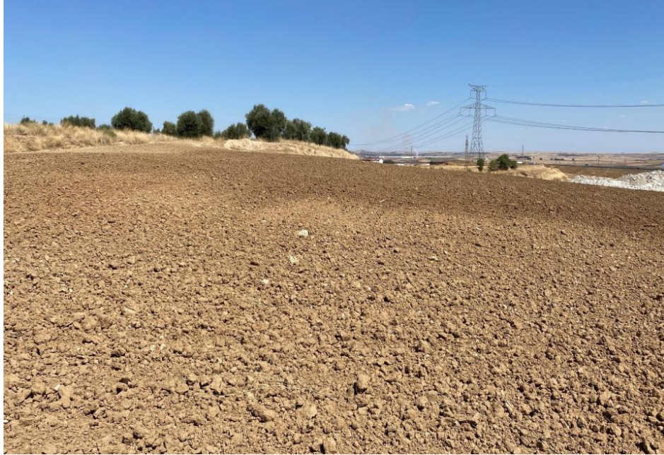
Restitución en Mina Toledo A
