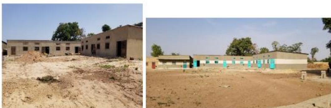
Construcción salas de clase
