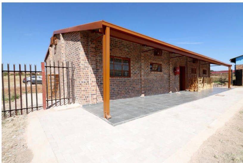
El exterior del laboratorio de ciencias renovado
