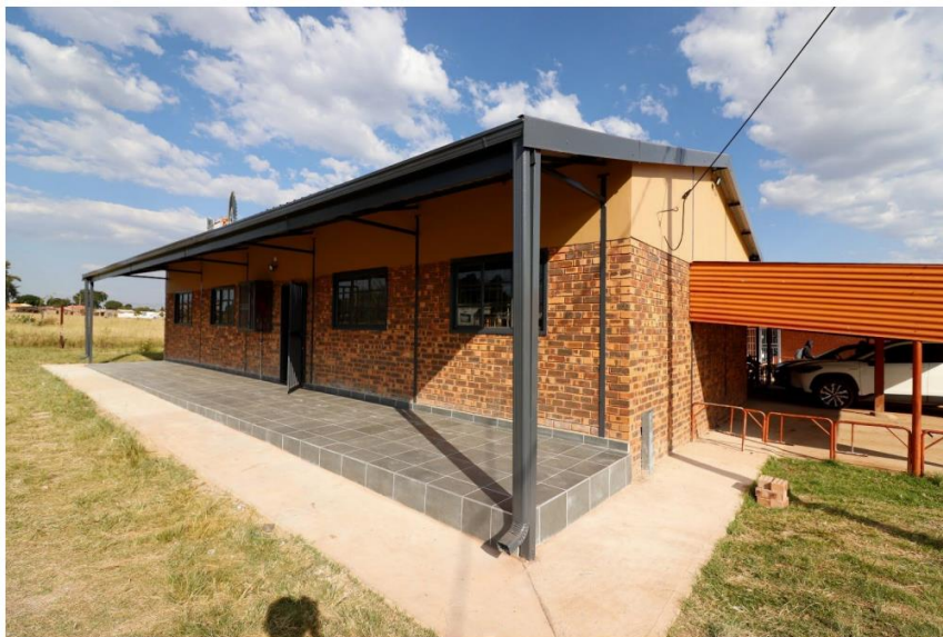
El exterior del laboratorio de ciencias renovado
