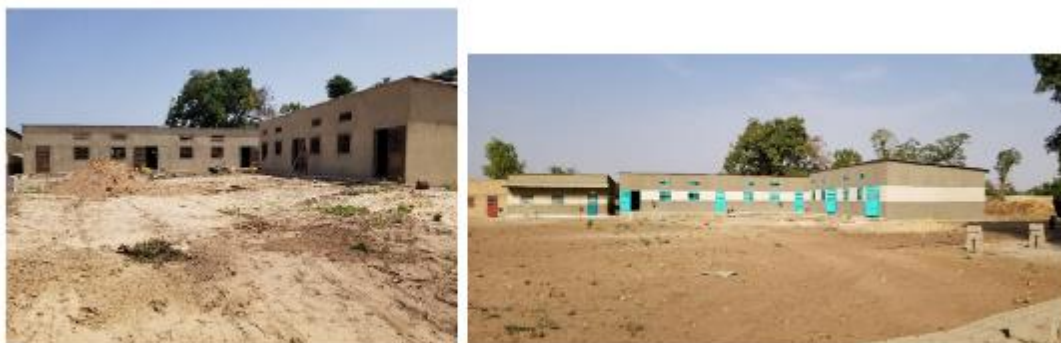
Construcción salas de clase
