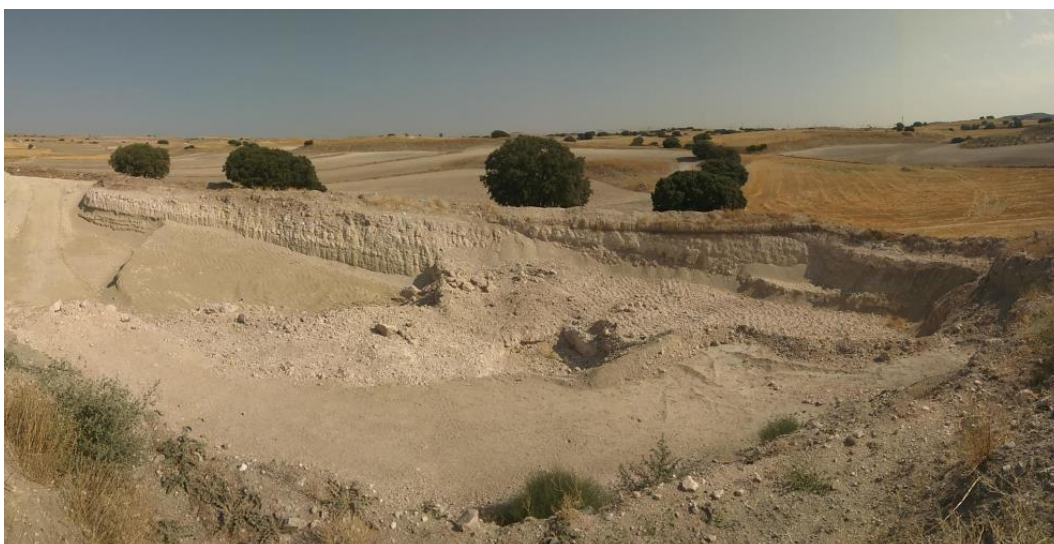
Trabajos de desmonte en Mina Cristina. Toledo.
