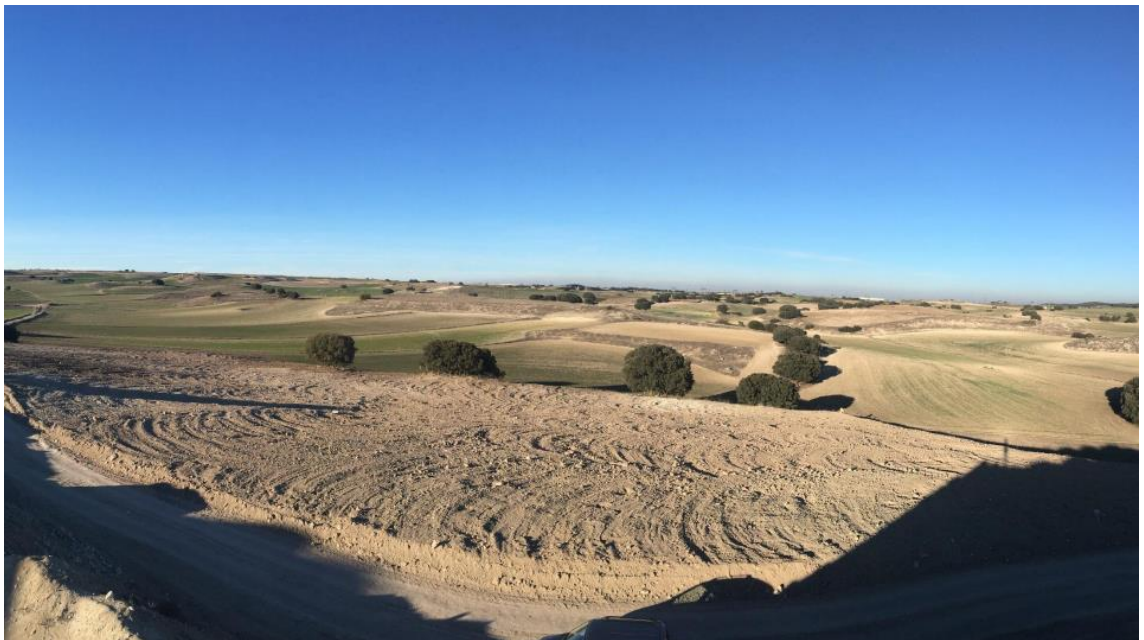
Trabajos de restitución en Mina Cristina. Toledo.
