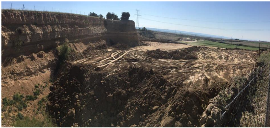
Explotación en Mina Toledo A
