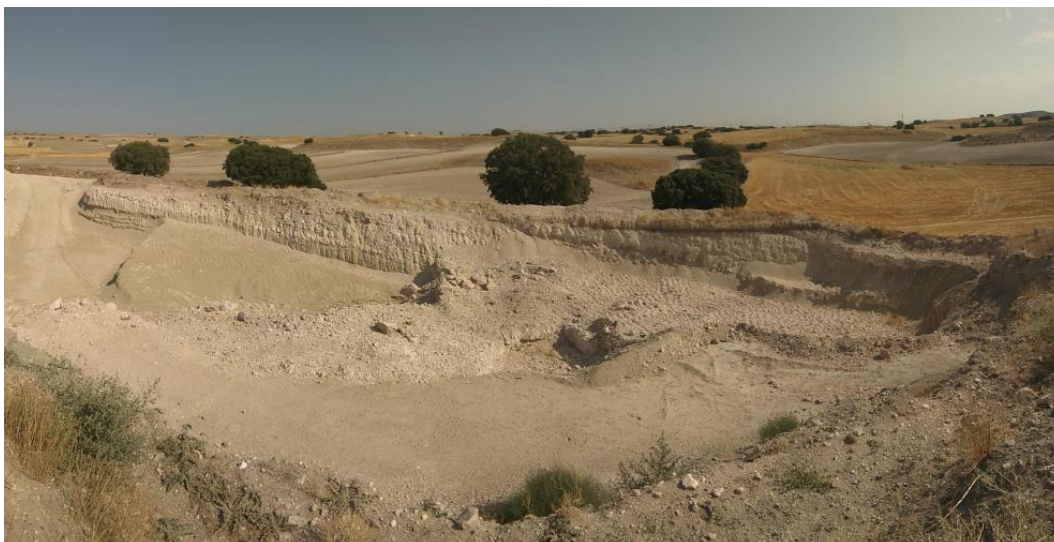
Trabajos de desmonte en Mina Cristina. Toledo.
