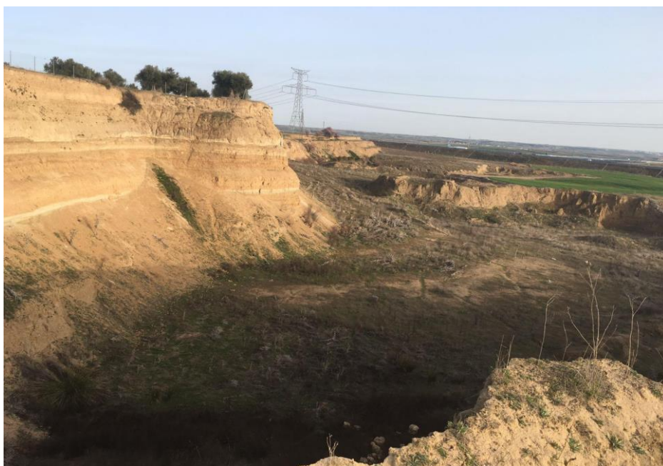
Desmonte en Mina Toledo A
