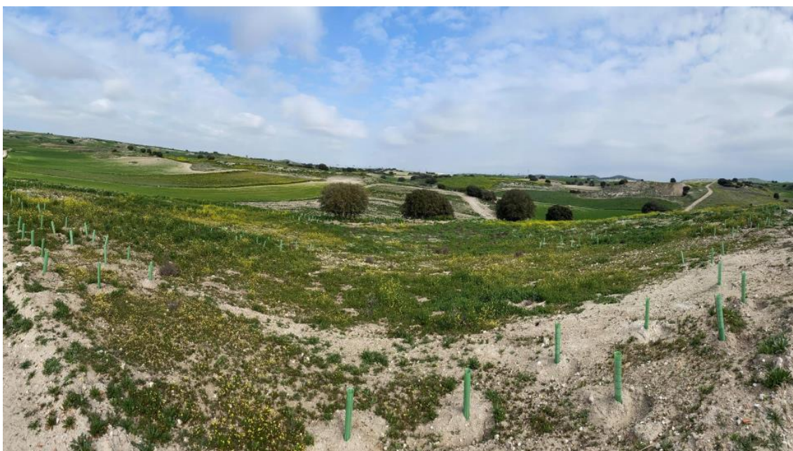
Trabajos de restauración en Mina Cristina. Toledo.
