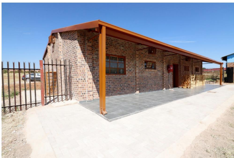
El exterior del laboratorio de ciencias renovado
